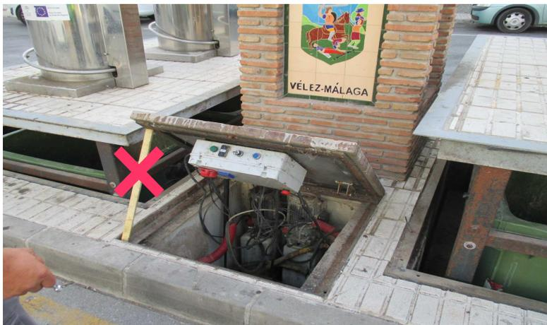
*Se deberá tener especial cuidado en el uso de elementos provisionales, tales como maderas, hierros, ladrillos... que puedan desplazarse provocando un accidente grave. Se recomienda la utilización de varillas con torniquetes en los extremos que se puedan fijar de forma correcta.*
