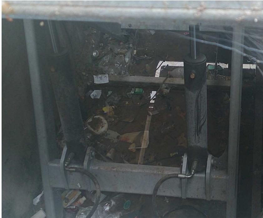
**Estructura soporte portalón:** es el elemento que se encarga soportar la plataforma peatonal. Esta estructura tendrá elementos diferentes dependiendo de si la plataforma peatonal es abatible o no.
