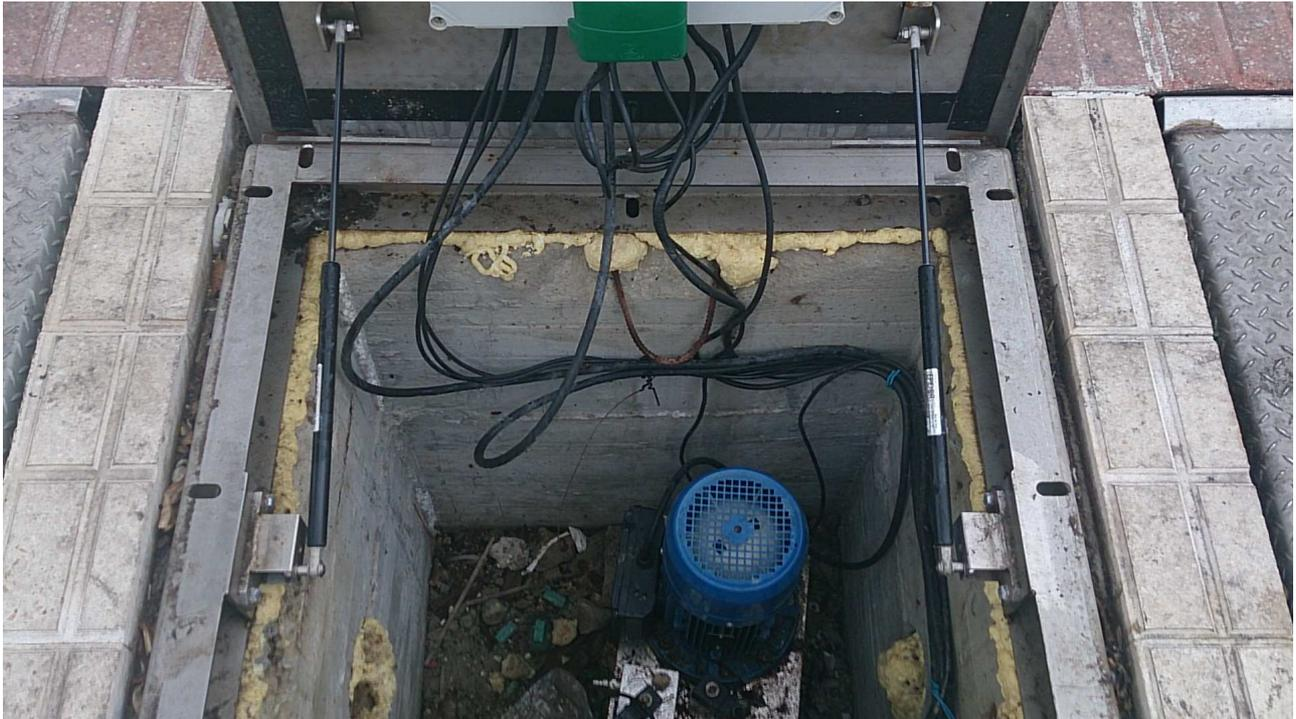
**4.3.5 Varilla o barra de seguridad para fallos del hidráulico.** Esta varilla permite realizar comprobaciones y trabajar dentro de la arqueta sin riesgos de atrapamiento por caída involuntaria de la tapa. Esta varilla puede estar integrada en el propio sistema (tipo capot vehículo) o será un elemento portátil que deberá llevar el operario. Recomendable que sea de metal con elementos de fijación en ambos extremos.
